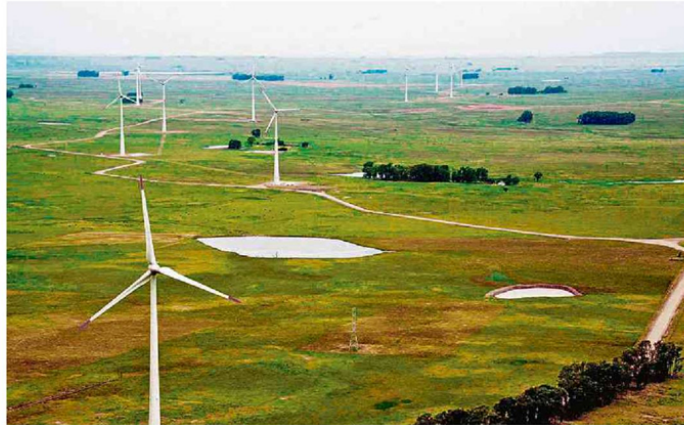
Empresa é a maior em geração de energia elétrica no país (na foto, complexo de Cerro Chato, na Fronteira Oeste)
