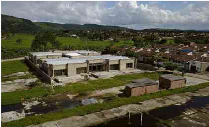
Obra abandonada de uma creche no município de União dos Palmares, em Alagoas Pedro Ladeira/Folhapress
