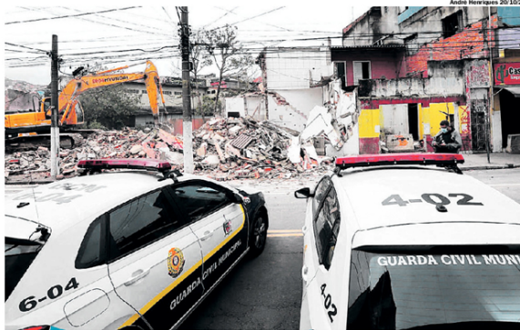
VILA SÃO PEDRO. Demolição dos imóveis começou em outubro do ano passado e terminou terça-feira
