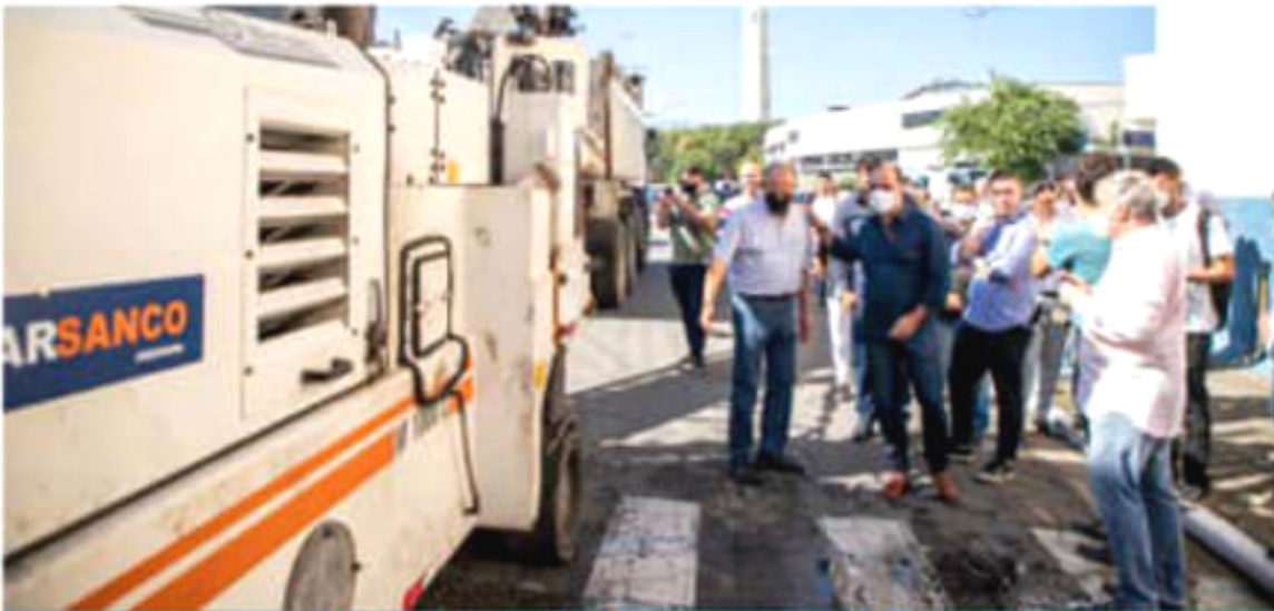
O programa Asfalto Bairro a Bairro percorrerá os 15 bairros da cidade
