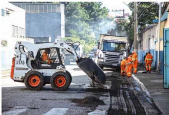
ASFALTO NOVO : primeiras ruas contempladas foi do Prosperidade
