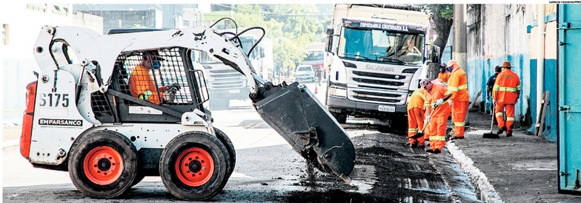
RECAPEAMENTO. Trabalhadores começaram as obras de revitalização das ruas e avenidas de São Caetano; na primeira fase, no Prosperidade, serão contemplados 50 mil metros quadrados de vias
