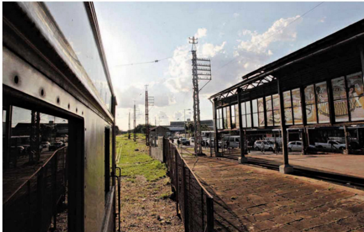
Área do complexo ferroviário usada pela Emdec para recolhimento de veículos; projeto prevê empreendimentos imobiliários no local
