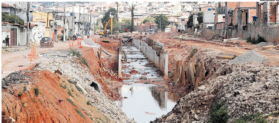
INVESTIMENTO. Obras do Complexo Cassaquera, que começaram em junho de 2020 e foram entregues em janeiro, ajudaram Santo André a ocupar posição de destaque no levantamento
