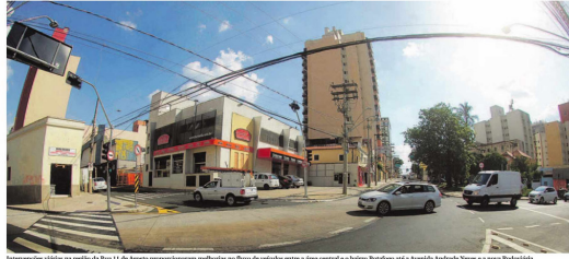
Intervenções viárias na região da Rua 11 de Agosto propiciaram melhorias no fluxo de veículos entre a área central e o bairro Botafogo e a nova Rodoviária
