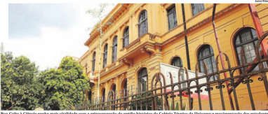
Rua Celso A. Garcia ganha nova vitalidade com a revitalização do prédio histórico do Colégio Técnico da Ypiranga e modernização das estruturas
