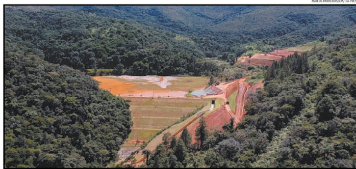
A Barragem Santa Bárbara, que precisou de intervenção no vertedouro, e a pilha de material (no alto, à direita): comunidade teme impactos do projeto
