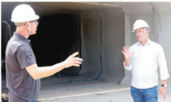
Após desassoreamento do Rio Saboó, serão instaladas aduelas de concreto, que servirão como tubulações
