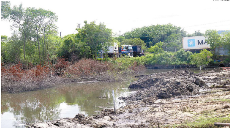
Obras têm como objetivo conter alagamentos na entrada de Santos. Serviço custará R$ 25 milhões, a serem pagos por empresa particular
