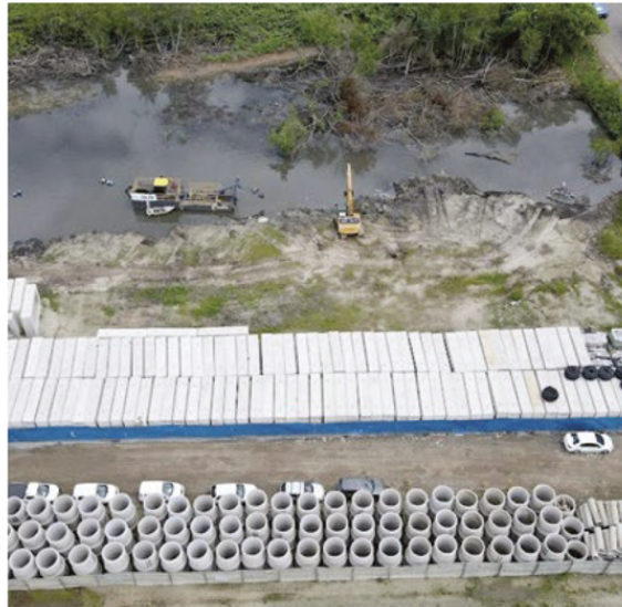
A instalação das galerias sob a Avenida Portuária será feita após o desassoreamento do Rio Saboó
