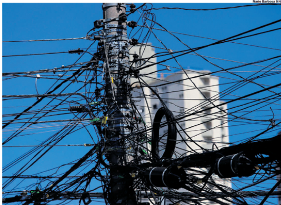
PROBLEMA GRAVE. Além da queda de árvore, emaranhado de fios também favorece queda de energia
