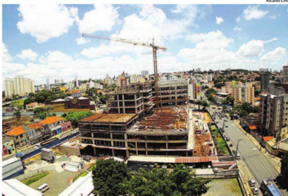
Região da antiga rodoviária de Campinas, onde está sendo construído um hospital: revitalização urbana
