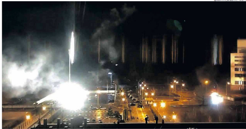
Unidade de geração de energia da usina nuclear de Zaporizhzhia, na Ucrânia, pega fogo após ataque da Rússia na região de Enerhodar
