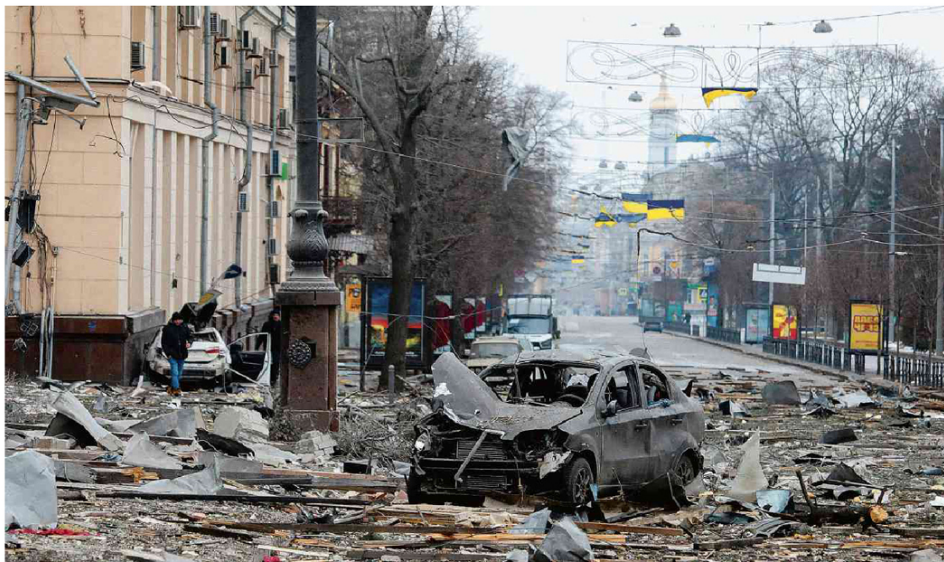
Prédio do governo regional de Kharkiv, segunda maior cidade da Ucrânia, parcialmente destruído após ataque de míssil russo. Václav Hlaváček/Reuters
