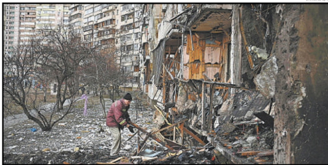
Homem tira destroços em edifício residencial bombardeado em Kiev, capital da Ucrânia, após ataque aéreo russo
