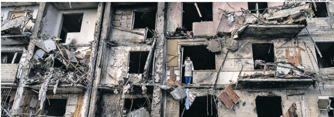
Edifício residencial na região sul de Kiev destruído por míssil lançado pelas tropas da Rússia; governo ucraniano recorre até a civis na tentativa de se defender da invasão
