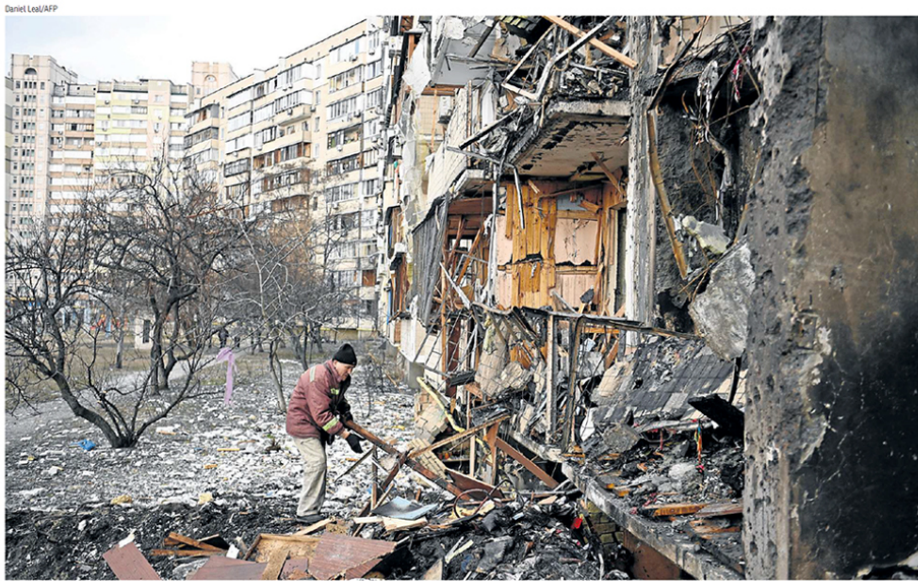
Homem vasculha os escombros de um edifício residencial atingido por bombas na Koshytsya Street, um subúrbio residencial ao Norte de Kiev
