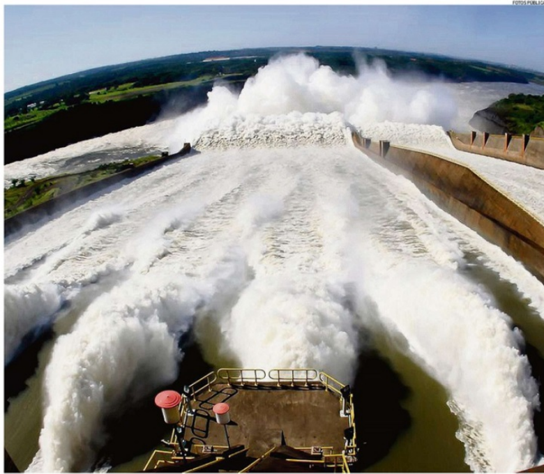
Hidrelétrica de Itaipu: encontro ontem aprovou transferência da participação da Eletrobras na usina e do controle da Eletronuclear para uma nova estatal
