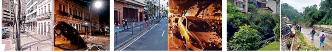
Rua da Imperatriz em frente ao prédio do Cefet: cenário de destruição
