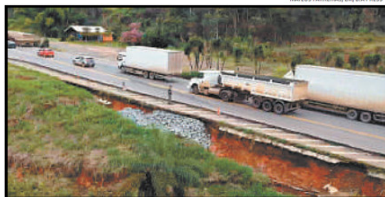
TRECHOS DESABANDO Visão proporcionada por imagem de drone na BR-381, onde trechos afetados por barreiras e buracos transformam o tráfego em arriscado e permanente abertura para os motoristas
