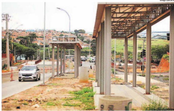
Serão destinados R$ 40 milhões para a conclusão das obras em vários trechos dos corredores do sistema BRT
