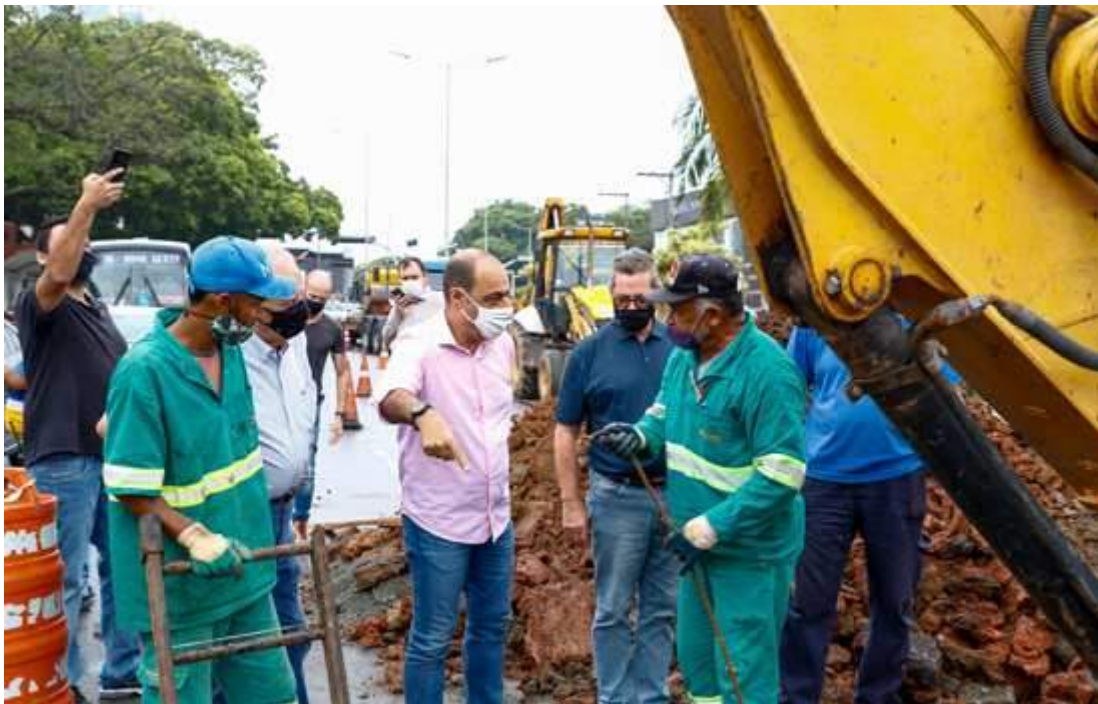
Prefeitura de São Caetano realiza obras na Avenida Goiás
