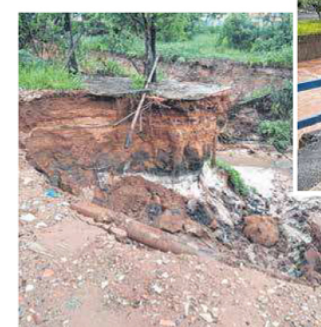
Cratera avançou sobre rua de terra no Jardim da Grama e gerou danos na tubulação de água
