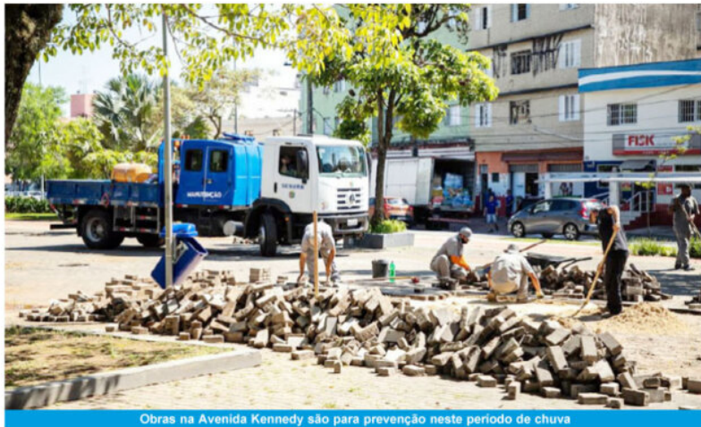
Obras na Avenida Kennedy são para prevenção neste período de chuva
