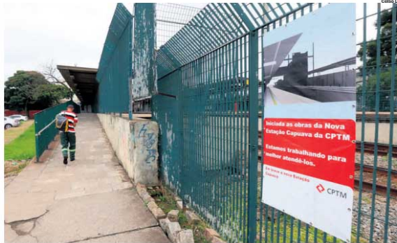
INFORMAÇÃO. Placas sinalizam a usuários início das obras e anunciam nova Estação Capuava da CPTM
