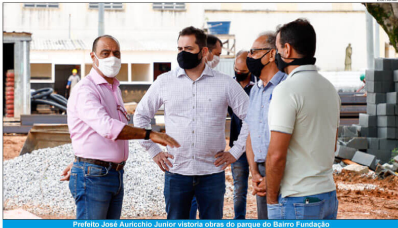
Prefeito José Auricchio Junior vistoria obras do parque do Bairro Fundação
