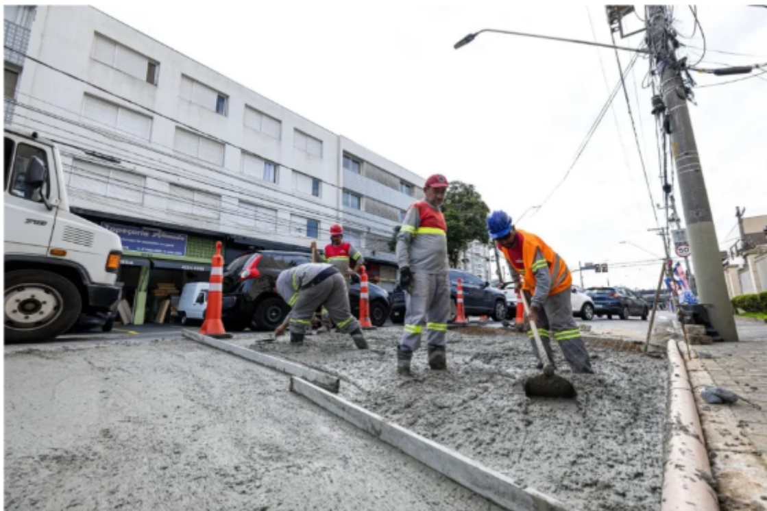
Avenida Goiás ganha pavimento concreto em pontos de ônibus – (Eric Romero / PMSCS)
