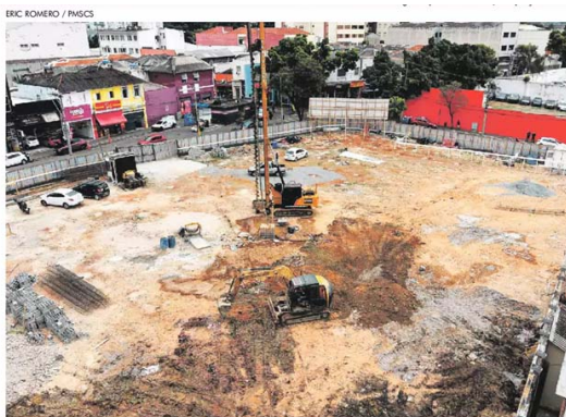
Execução das estacas hélice contínua começou nesta semana e tem previsão de conclusão até a primeira quinzena de setembro, preparando o estuário para o início dos próximos etapas
