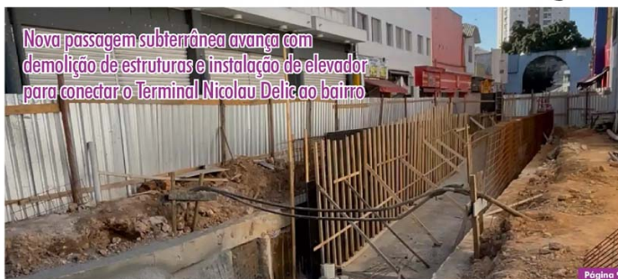
Projeto entra em fase decisiva com demolição de estruturas, instalação de elevador e manutenção da circulação de pedestres; iniciativa integra pontos de combate às enchentes com obras de drenagem, espeta a reservatório de 18 milhões de litros
