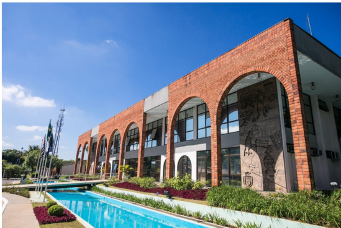
Palácio da Cerâmica
