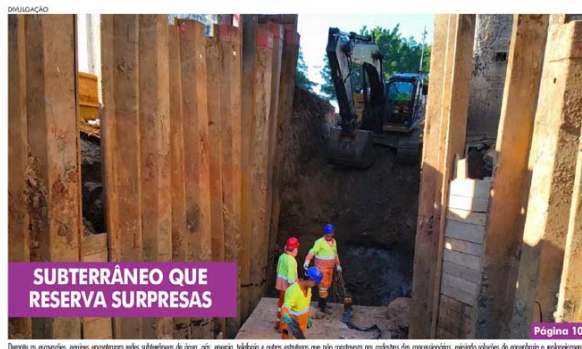
Divulgação. Durante as escavações, equipes encontraram redes subterrâneas de água, gás, energia, telefonia e outros cabos que não constavam nos cadastros das concessionárias, exigindo soluções de engenharia e replanejamento.
