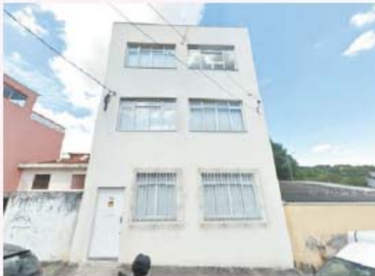
Fachada de prédio sede da Telure em São Caetano
