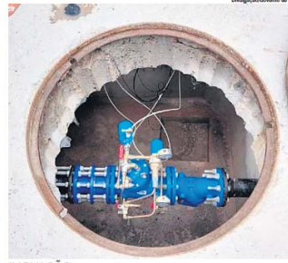
INOVAÇÃO. O SMR realiza ajustes automáticos de forma remota
