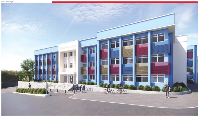
FUTURA escola ocupará terreno onde existiu por seis décadas um prédio inacabado no Bairro Fundação
