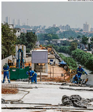
Obras do BRT-ABC no Viaduto Mauá, em São Bernardo do Campo
