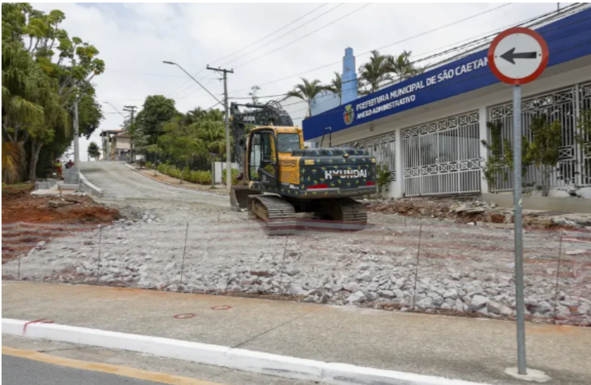
Obras da Rua Eduardo Prado entram na fase final e reabertura ocorre em abril - Foto: Eric Romero / PMSCS
