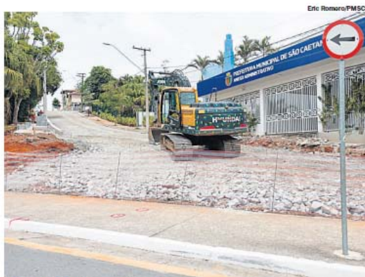
PROGRESSO. Intervenções avançam à medida que a chuva para
