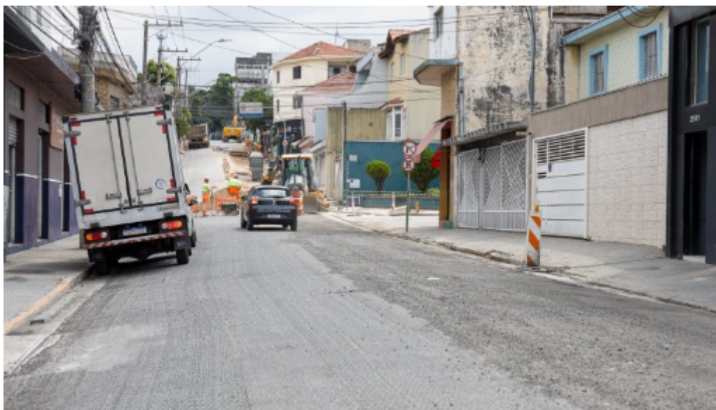
programa Drenar São Caetano na Rua Amazonas
