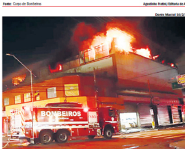
EM 2026. Fogo destruiu parte da Armariinhos Fernando, em Sto. André
