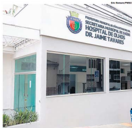
EXAME: Hospital de Olhos em São Caetano é um dos que realizam avaliações
