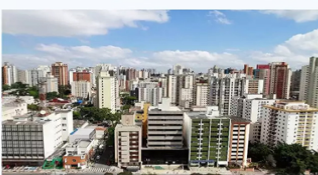
Imóvel em construção otimista em 2025 e setor projeta estabilidade no preço e alta da demanda para 2026
