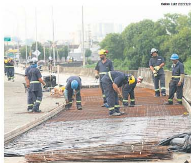
BRT-ABC. Next Mobilidade afirma que 773 pessoas trabalham na obra
