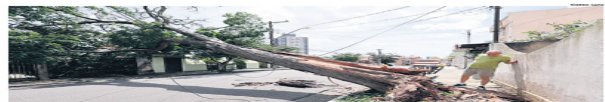
CAOS. Árvore na Rua Sulca, em São André, caiu sobre uma casa e destruiu a rede de distribuição elétrica do bairro
