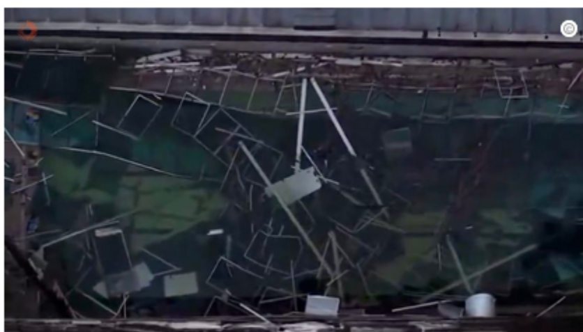
Vídeo que circula nas redes sociais mostra o desabamento do teto de academia em São Caetano do Sul (SP) após as fortes chuvas
