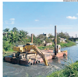
ACÕES. Estado realiza retirada de sedimentos dos cursos d'água
