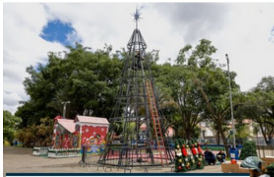
Árvore de Natal em processo de montagem em São Caetano
