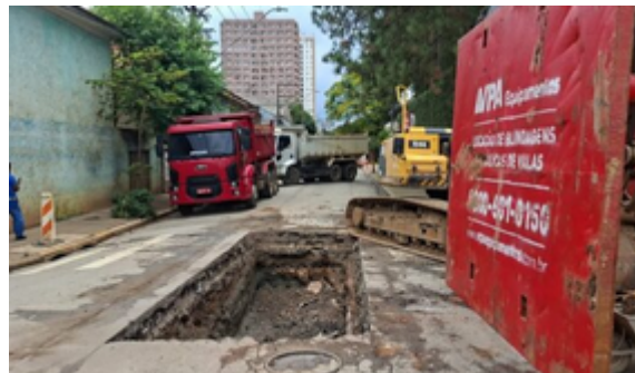
Obras de drenagem na Rua Ceará, no bairro Fundação
