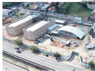
META. Hospital Vila Luzita, em Sto. André, está com obras avançadas
